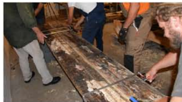
11. Prasowanie, ściskanie bretów dna
