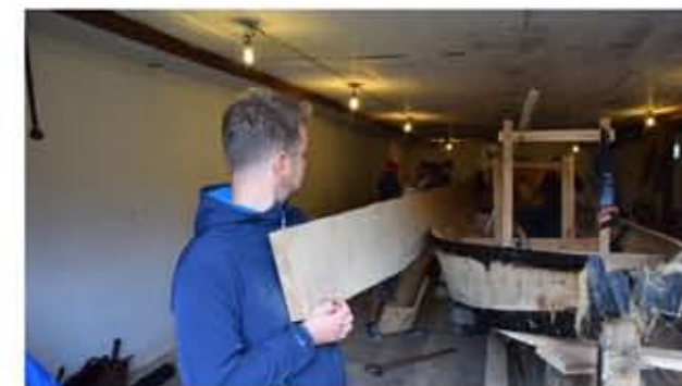
16. Montaż trzeciego pasa burtowego tzw. wasserłaty
