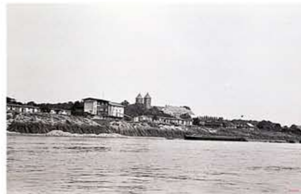
Witki wierzbowe nad brzegiem Wisły w Czerwińsku nad Wisłą służące do budowy główek (ostrog wodnych)
