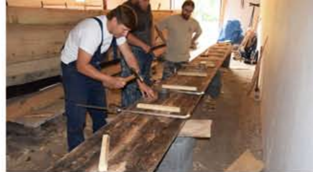
13. Montaż łączników na czas budowy
