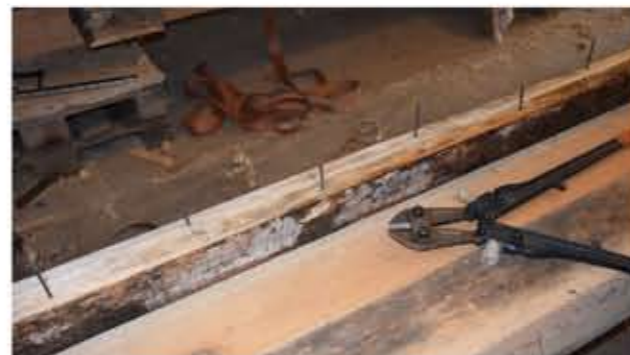
10. Przygotowanie do dyblowania dna
